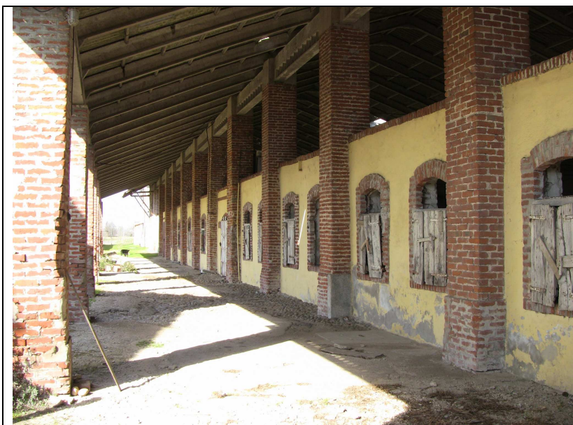
Il porticato della ex stalla verso l'abitazione
