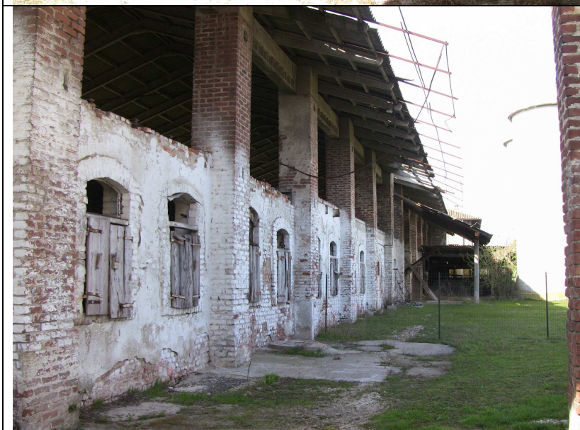
Il retro della ex stalla verso la corte "rurale" della cascina
