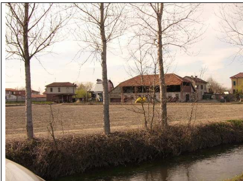
L'ampio fienile e le strutture tecnologiche a corredo
