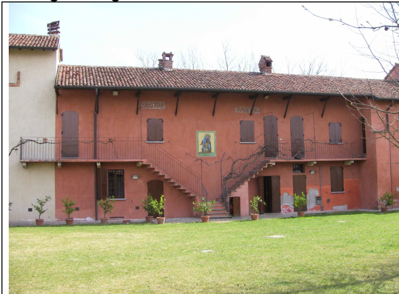
L'edificio di abitazione, con l'edicola in centro e la scala che dà accesso al doppio ballatoio
