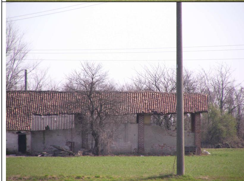
Il fienile deposito perpendicolare alla tettoia dell'edificio principale
