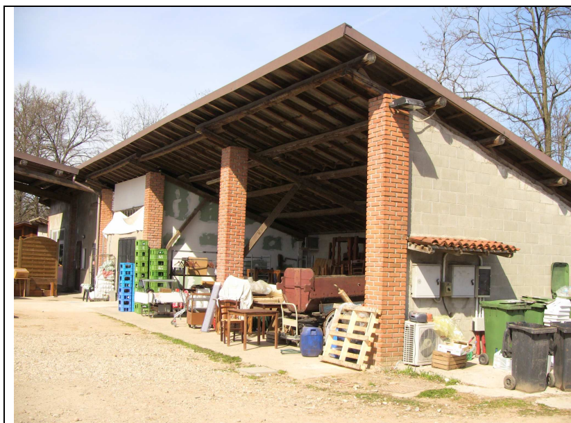
I depositi esistenti di recente costruzione
