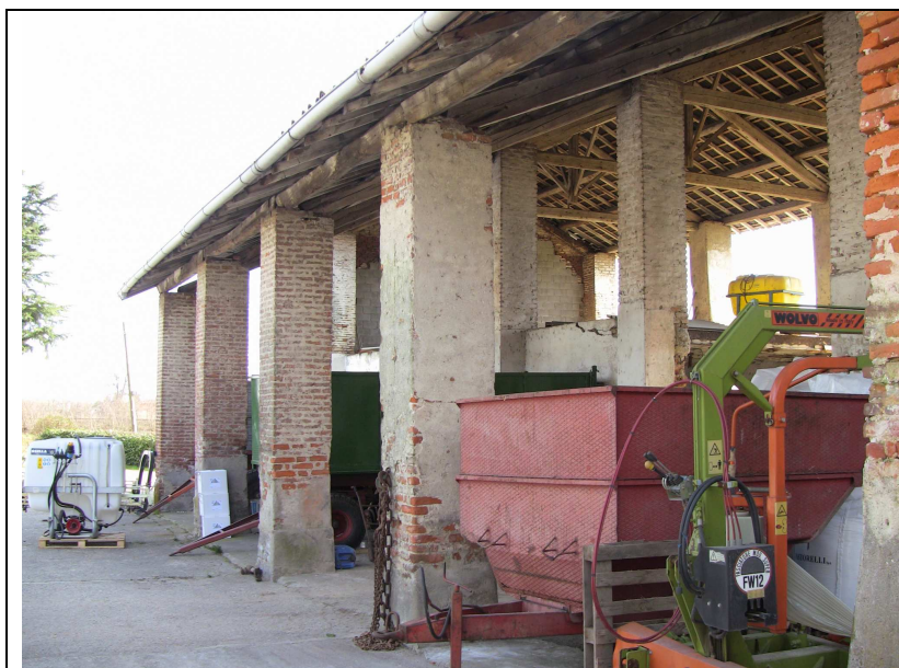
Il deposito all'abitazione adiacente
