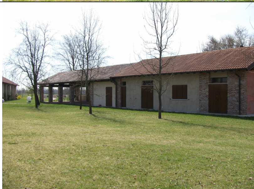
Il rustico fronteggiante con la tettoia terminale utilizzata quale sala ristorante all'aperto.
