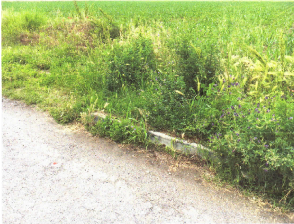
Cordolo lato Nord strada MEROPE s.r.l.
